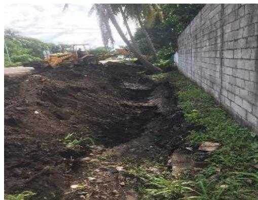
15. Supervisión “CONSTRUCCION SISTEMA DE TRATAMIENTO DE AGUAS RESIDUALES CASCO URBANO, MASAGUA, ESCUINTLA.”
