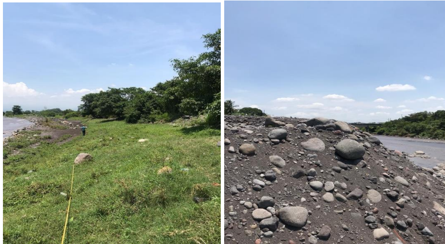
14. Visita Técnica “MEJORAMIENTO CUNETAS COLONIA LAS VICTORIAS, MASAGUA”
